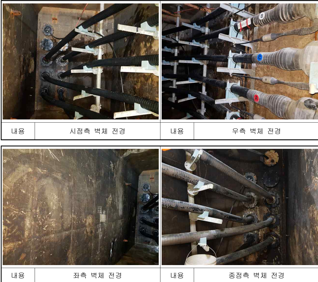
【사진 2.5】 덕소~진건#2 전경
