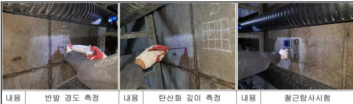
【사진 2.17】 덕소인출 재료시험 전경
